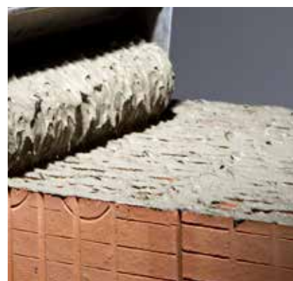
nanášení válcem na žebra cihel
